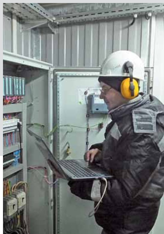
Специалист «АГМ-СЕРВИС» проводит работы по наладке системы автоматического управления азотной станцией
